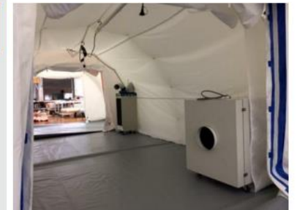
※テント内に医療用陰圧装置膜を設置した例
